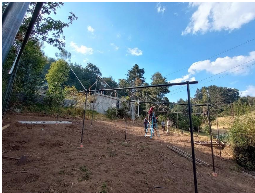
Imagen 2: Colocación de vigas.
