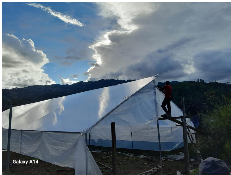
Imagen 4: Finalización del invernadero
