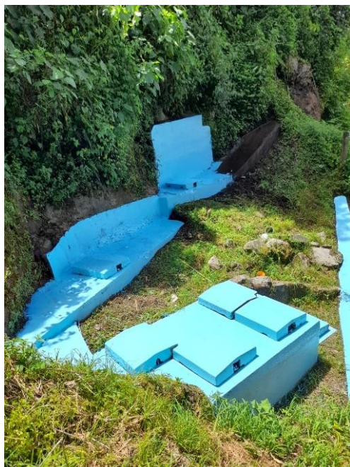
Mantenimiento en fuentes de agua Siete Tambores
