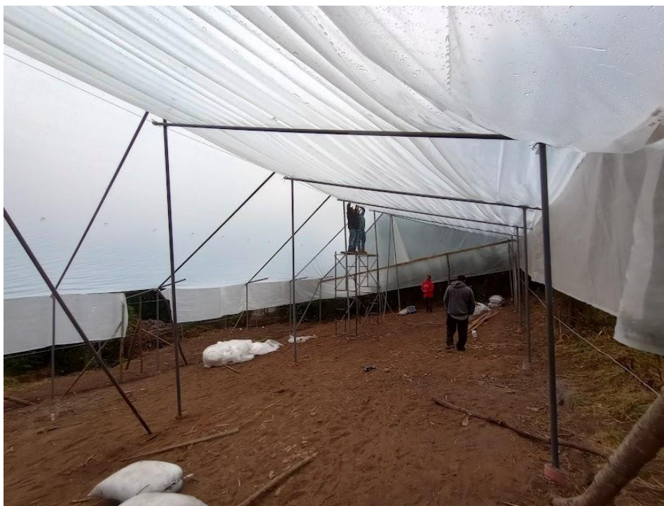
Imagen 3: Colocación de la malla antiafida y nylon.
